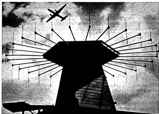
Bild 12. Versuchsanlage eines Dopplerpeilers auf dem Flughafen Stuttgart-Echterdingen
